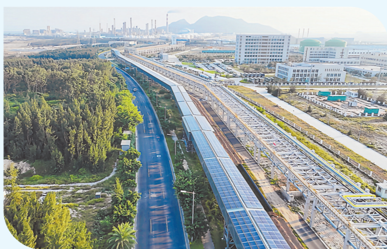
古雷石化园区公共管廊 (资料图片)
