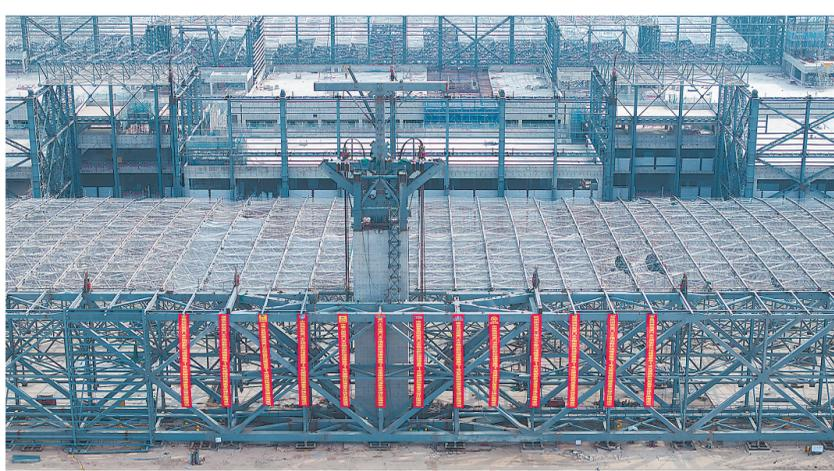
3月29日,厦门太古翔安机场维修基地项目1号机库钢结构网架屋盖首次提升顺利完成,为这座世界单体规模最大、跨度最大的民航飞机维修机库结构工程顺利竣工奠定重要基础。
