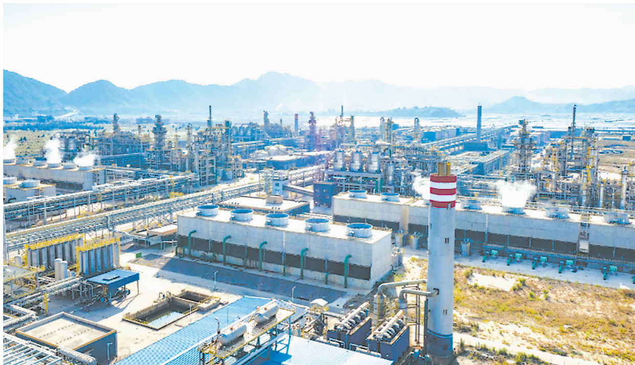
俯瞰申远新材料一体化产业园。 恒申集团 供图
