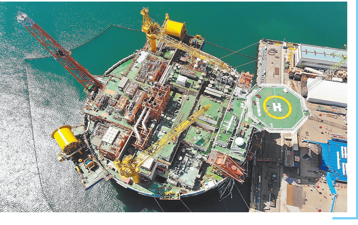
“海葵一号”建造完工(无人机照片,4月26日摄)。新华社
