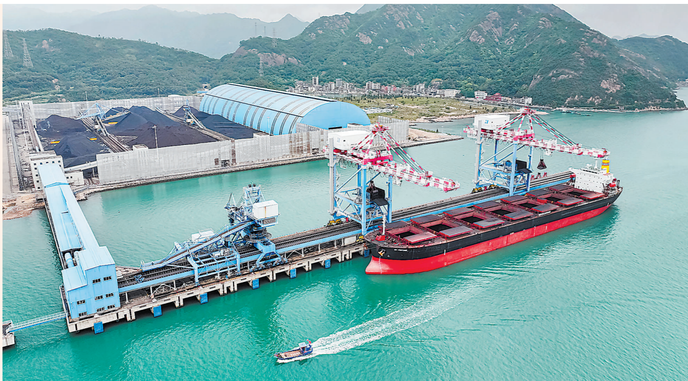
28日,罗源湾华能(福建)海港码头,办好入境边检手续的中国香港籍“财富”轮正在抢抓时间卸载7.3万吨电煤。据悉,华能(福建)海港有限公司地处罗源湾北岸,是立足福建、面向内陆的进口煤中转储备基地,主要为系统内电厂提供煤炭装卸、储运、供应、中转等服务。本报通讯员 井溯 谢贵明 摄
