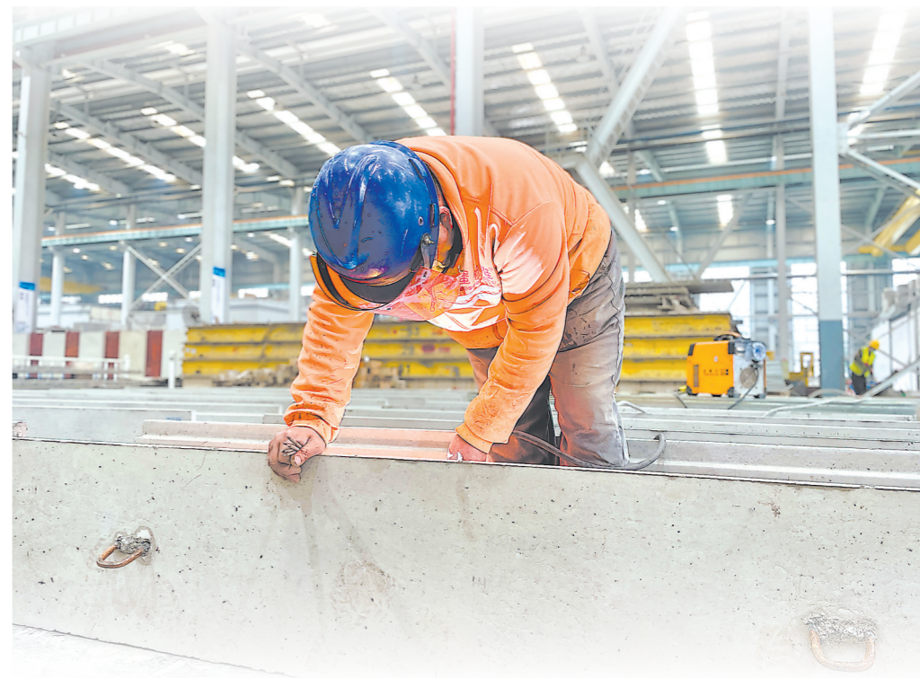
在中建海峡(闽清)绿色建筑科技产业园,工人按工序生产预制构件。 本报记者 林霞 摄
