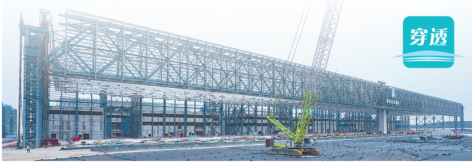
厦门市众多公建项目中,装备式技术频繁应用。图为位于厦门翔安机场的太古维修基地施工现场。(中建八局供图)
