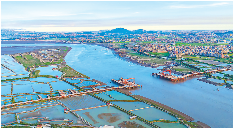
木兰溪入海口的三江口大桥正在建设中。李翔 摄
