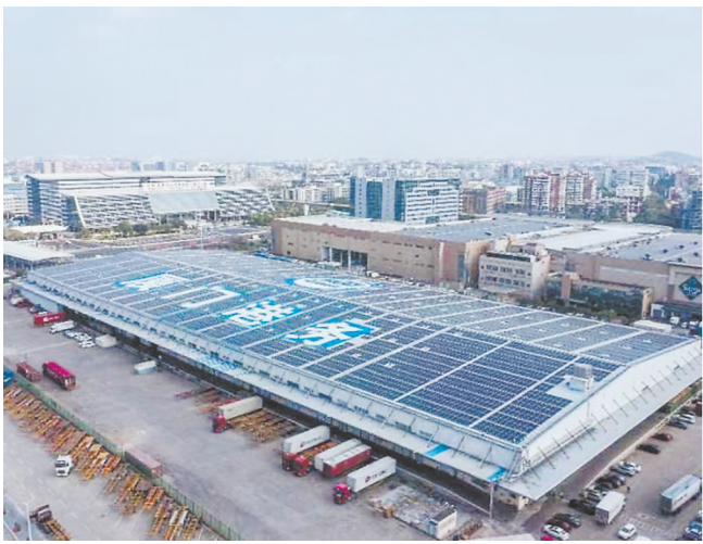
厦门港区的屋顶光伏
