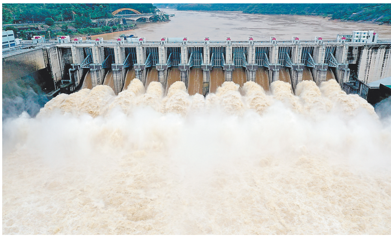
连日来,受强降雨影响,闽江流域水位连续上涨。为减轻闽江上游防汛压力,水口水电站开启泄洪。图为17日,水口水电站持续开闸泄洪。 王旺旺 摄
