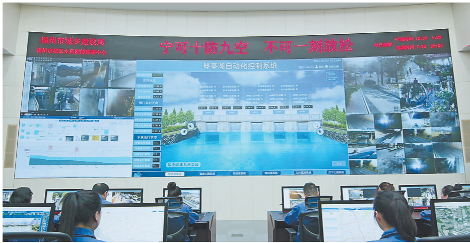
连日来,福州市城区水系联排联调中心的指挥大厅里,工作人员紧盯城区水系科学调度系统,实时调度。(受访者供图)
