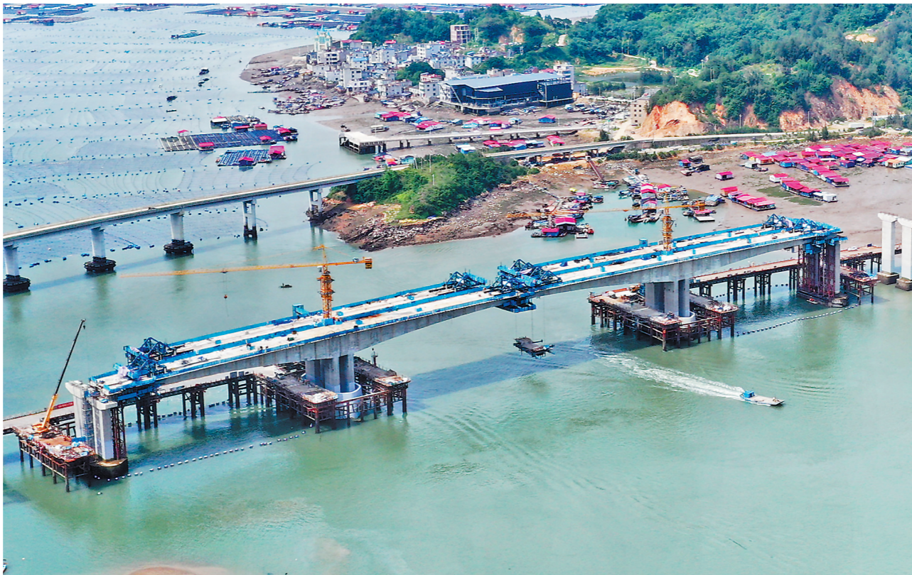
21日,位于霞浦县东安岛的宁上高速项目A2标段关门江水道跨海大桥施工现场一派繁忙景象。据了解,该跨海大桥位于东洋湾口关门江水道最窄处,全长862米,起32米深海域长300米,最深处达43米。 王旺旺 摄
