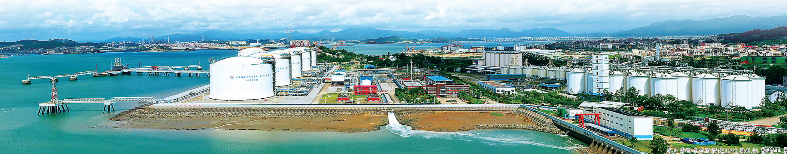
秀屿港永荣己内酰胺LNG接收站。 杨艳平 摄
