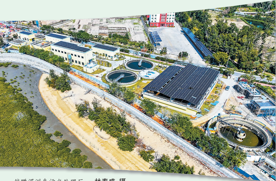
俯瞰湄洲岛污水处理厂。林春盛 摄
