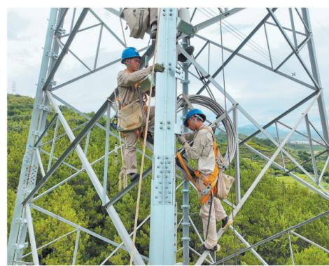
24日,在连江县东湖镇天竹村,电力施工人员为500千伏福门I路61号塔安装角钢主材以补强塔身,确保台风登陆期间线路的安全可靠供电。
